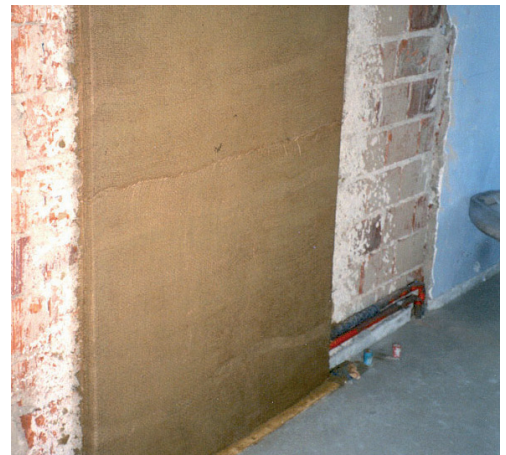
Grobputz mit eingearbeiteter Jutematte als Untergrund für den Feinputz
