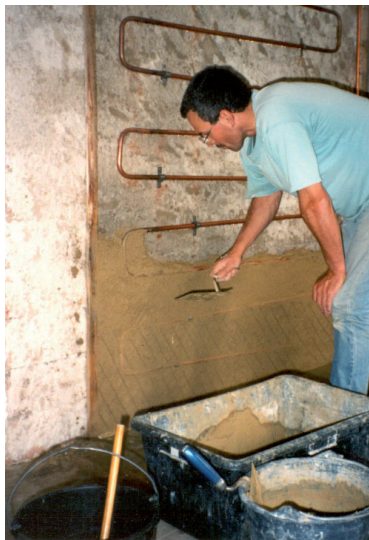
Verputzen eines Wandheizkörpers
